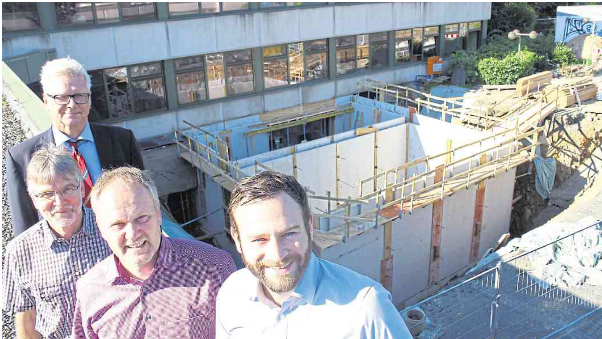
Sozusagen „unterirdisch“ wird derzeit an den Heizungskeller der BBS Betzdorf-Kirchen angebaut: Unter dem Schulhof am Eingangsbereich entsteht eine neue Hackschnitzelheizung mit Silo. Hinter dem extrem klimafreundlichen Projekt stehen wie ein Mann Schulleiter Michael Schimmel (hinten) und (vorn, von links) der Kreisbeigeordnete Günter Knautz, Projektleiter Dirk Eiteneuer (Gebäudemangement Kreisverwaltung) und Kreisklimaschutzmanager Stefan Glässner.
